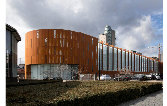
Parkeergarage Spoorzone Zwijzen Fotograaf: BASE Photography
